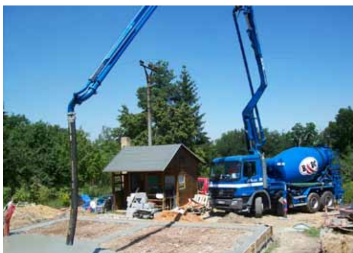
Obr. 6: Lití železobetonové desky
