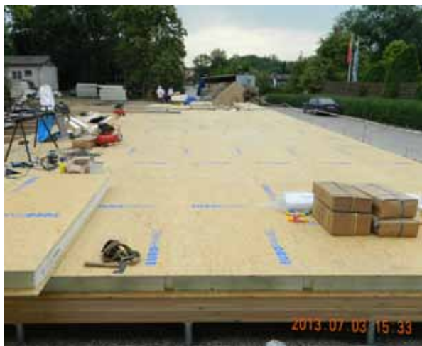
Obr. 8: Montáž základové desky ze SIP
