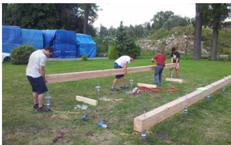
Obr. 7: Montáž modřínových hranolů
