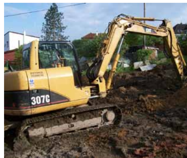
Obr. 1: Bagrování základů pro železobetonovou desku
