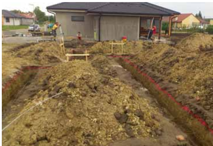
Obr. 2: Výkopy základových pasů
