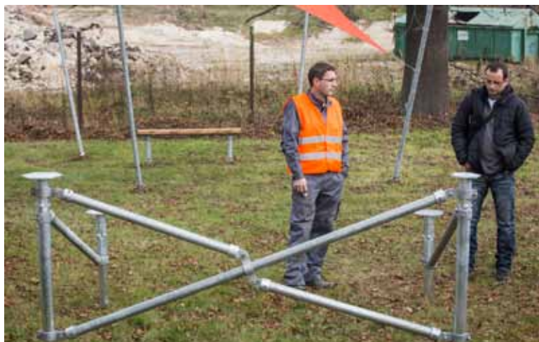
Obr. 9: Způsob zavětrování zemních vrutů pro desky umístěné vysoko nad terémem nebo na nerovných pozemcích
