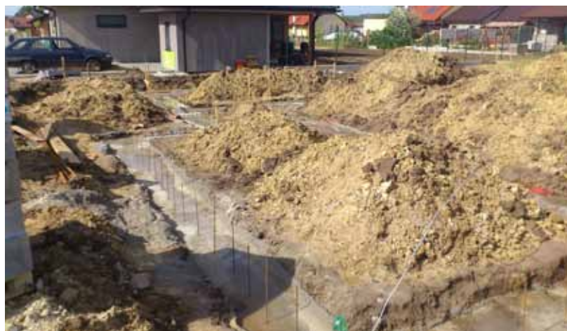
Obr. 5: Vybetonovaný základový pas
