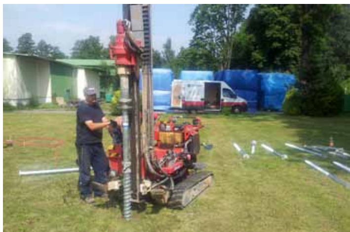
Obr. 4: Instalace zemních vrutů
